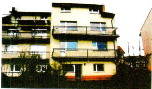
Widok budynku od strony ogrodu
