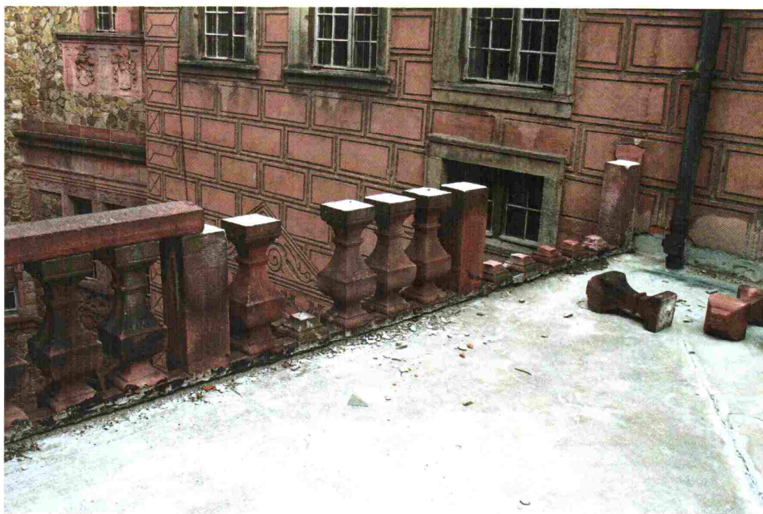
43. Uszkodzona kamienna balustrada tarasu
