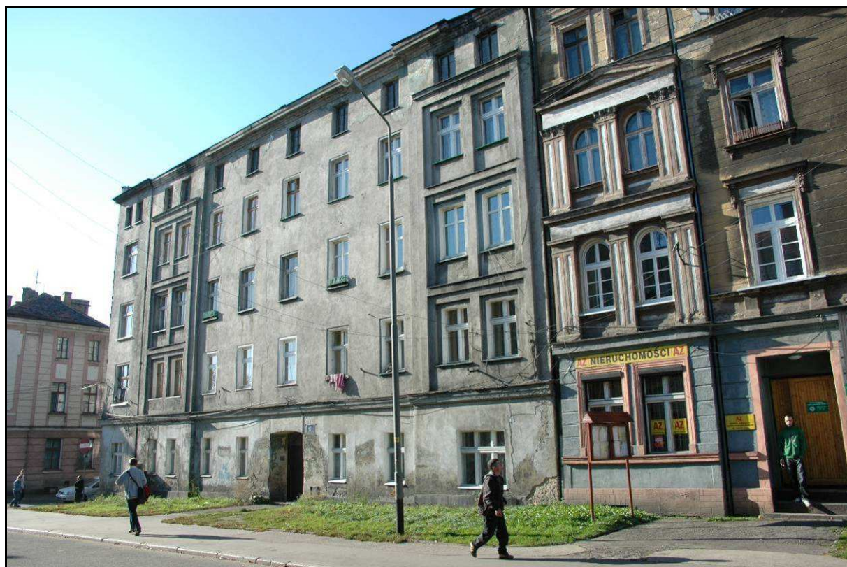
Fotografia 4. Zniszczone kamienice ulicy Lewartowskiego. W ich otoczeniu zaniedbana zielen.
