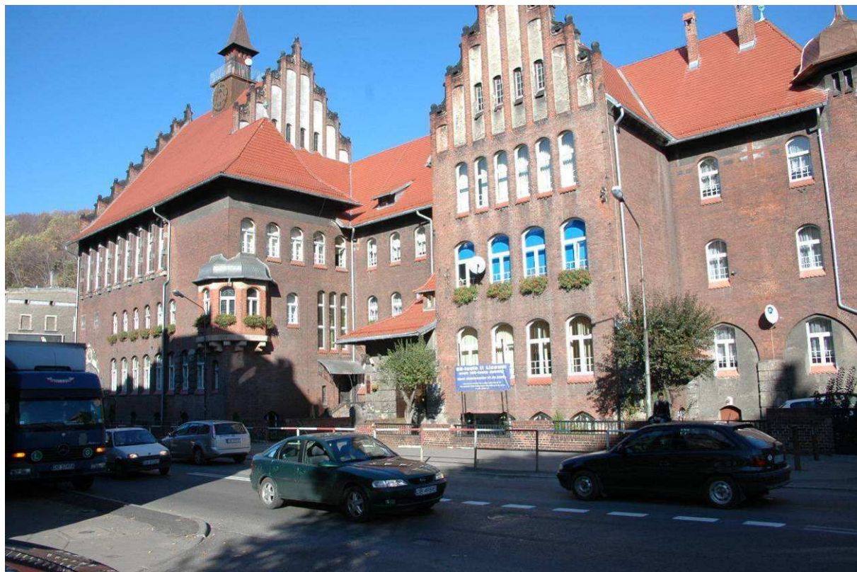
Fotografia 12. Wymagający remontu budynek Zespołu Szkół nr 2.
