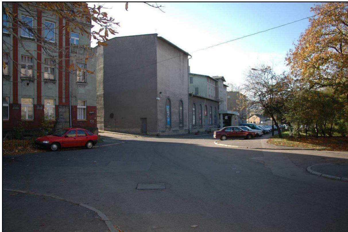
Fotografia 11. W głębi Placu Teatralnego wymagający remontu i przebudowy budynek Teatru Dramatycznego.
