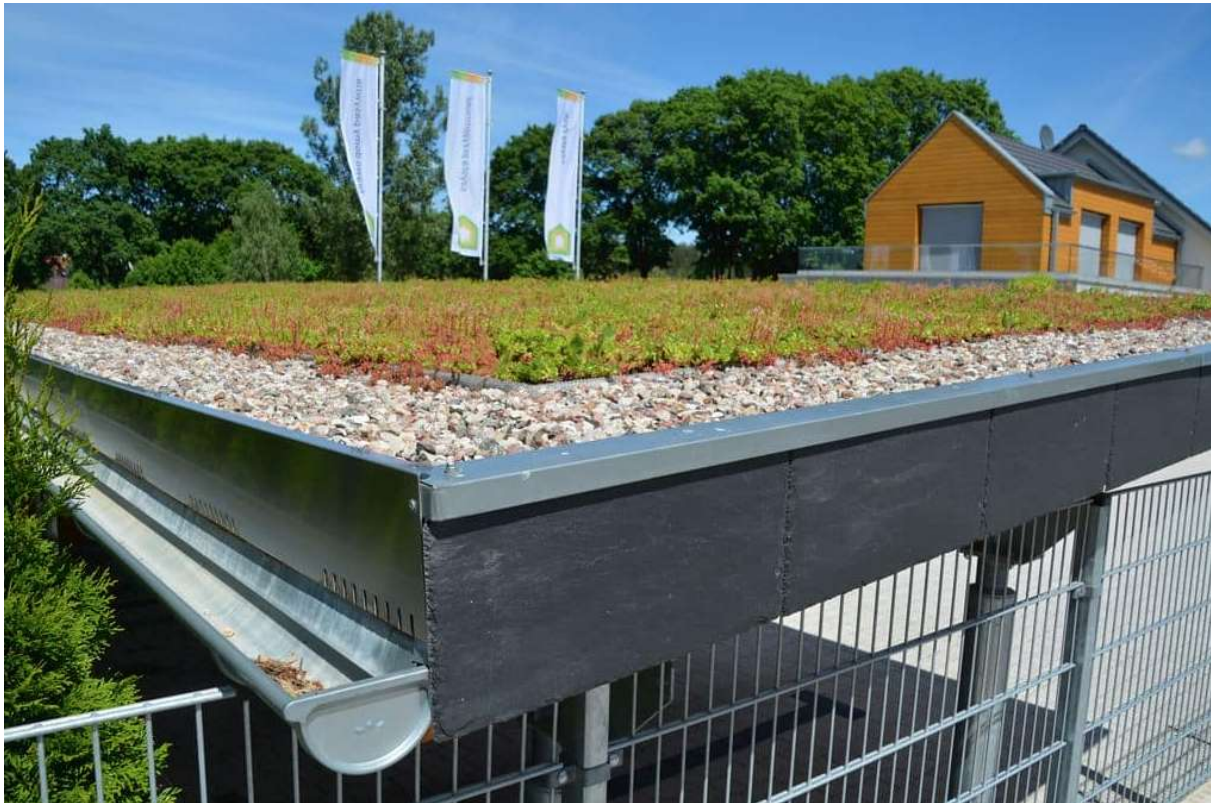
Fot. 4. Zielony dach ekstensywny. Źródło: www.dachyzielone.pl (dostęp 19.02.2026 r.)
