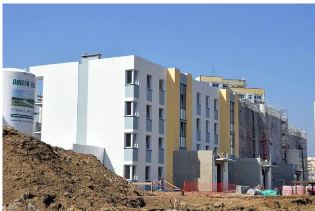
Budowa mieszkań komunalnych w dzielnicy Podzamcze
