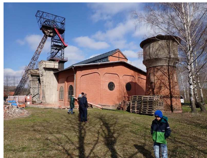
Fot. 6 Widok na zabudowę historyczną szybu „Irena” (źródło: zasoby własne).
