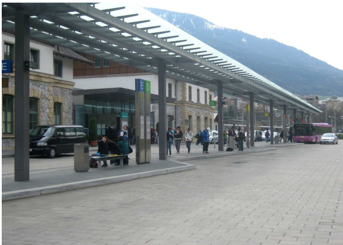
Rys.VIII.7. Stacja Landeck – Zams. (źródło: zbiory własne)
