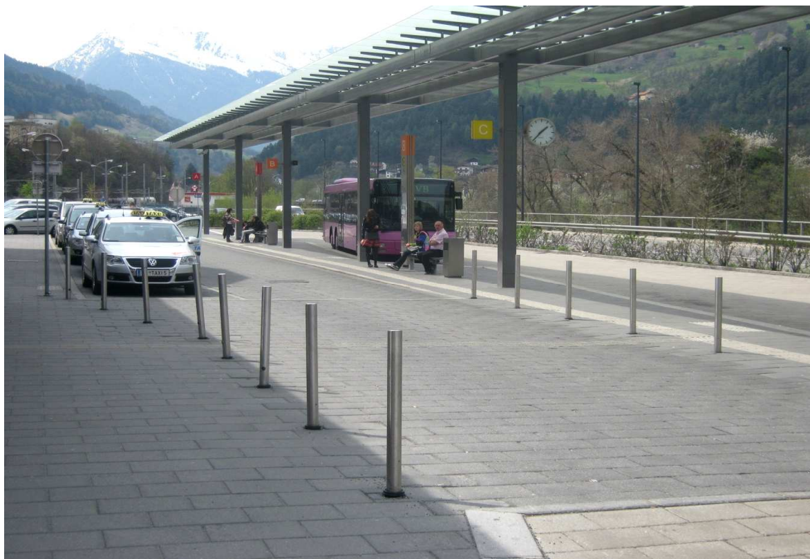
Rys.VIII.9. Stacja Landeck – Zams. (źródło: zbiory własne)
