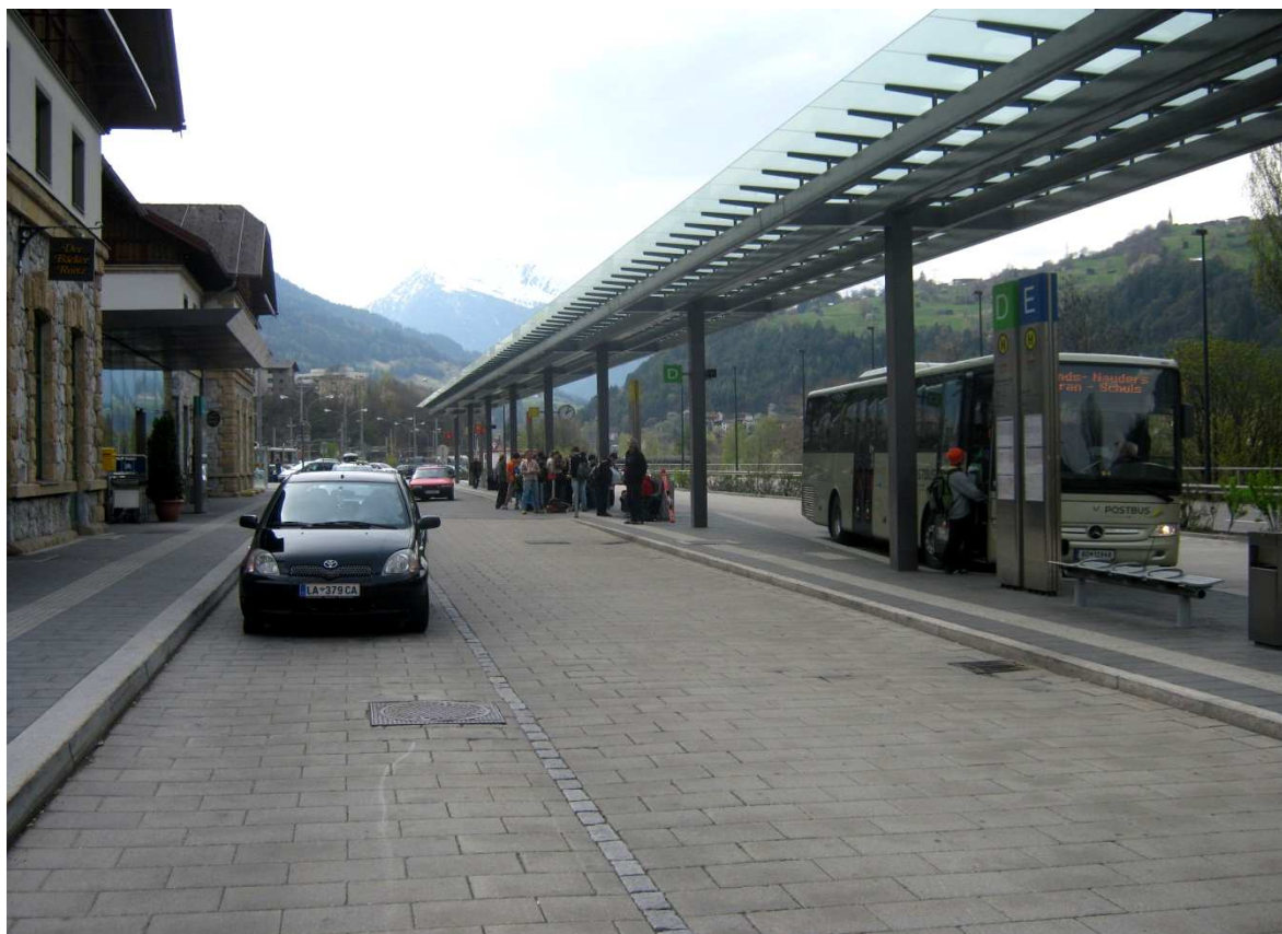
Rys.VIII.10. Stacja Landeck – Zams. (źródło: zbiory własne)
