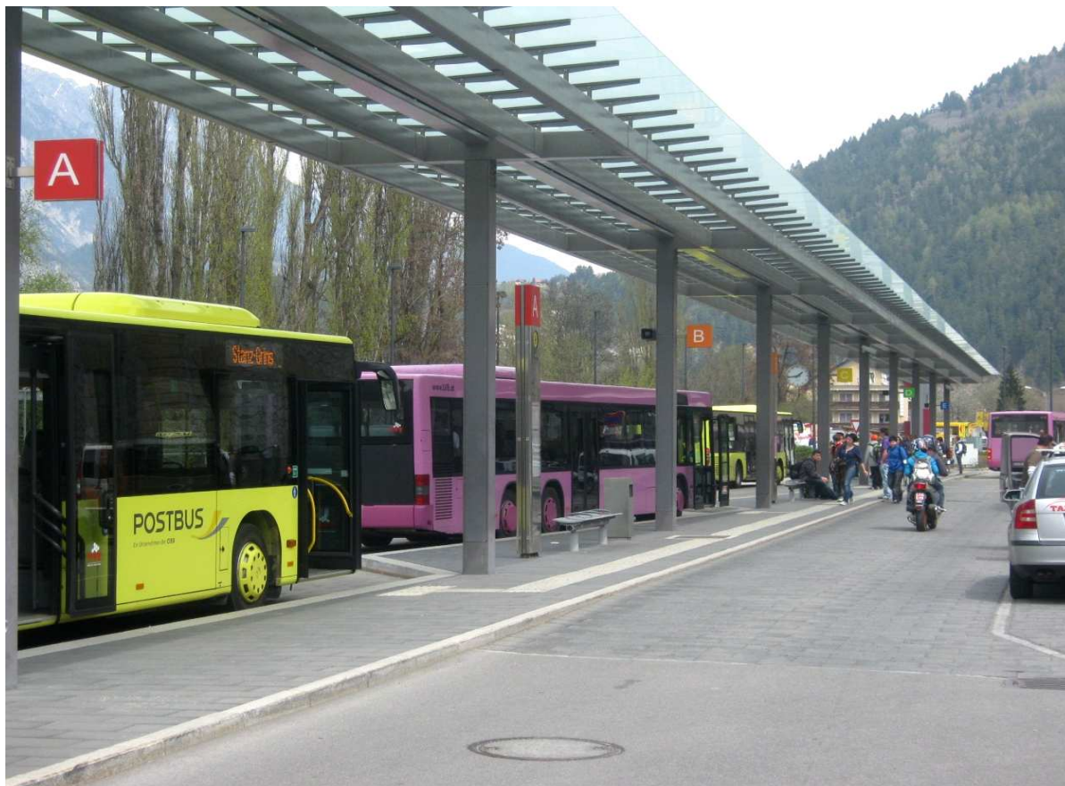
Rys.VIII.8. Stacja Landeck – Zams. (źródło: zbiory własne)
