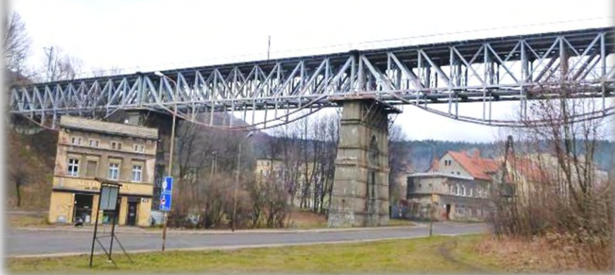
Zdjęcie 29. Wiadukt kolejowy nad ul. Niepodległości
