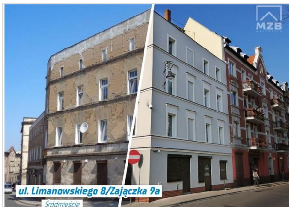
Fot. Wspólnota mieszkaniowa przy ul. Bolesława Limanowskiego nr 8 / ul. Gen. Józefa Zajęczka nr 9a w Wałbrzychu – remont elewacji, projekt ujęty w Gminnym Programie Rewitalizacji, realizacja ze środków własnych (źródło: MZB w Wałbrzychu)
