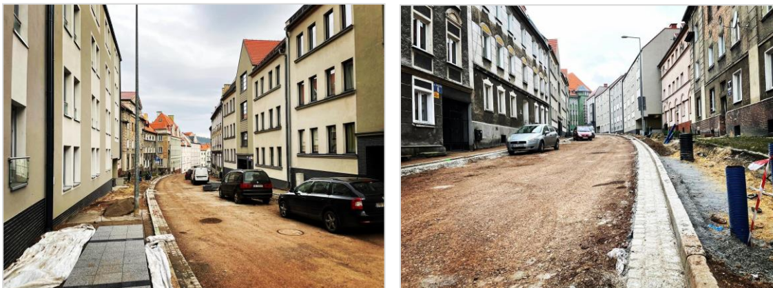
Fot. Ulica Staszica w trakcie przebudowy - rok 2021 [źródło: FB ZDKiUM ]
