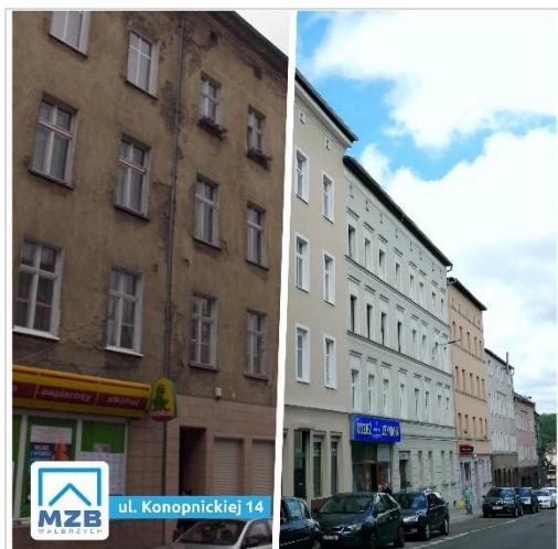
Fot. Wspólnota Mieszkaniowa przy ul. Marii Konopnickiej nr 14 w Wałbrzychu – remont elewacji, projekt ujęty w Gminnym Programie Rewitalizacji, realizacja ze środków UE (źródło: MZB w Wałbrzychu)
