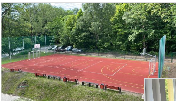
Fot. Budynek przy ul. Moniuszki 118 – nowa siedziba Młodzieżowego Ośrodka Socjoterapii, rok 2022 [źródło: FB Wałbrzych Moje Miasto]
