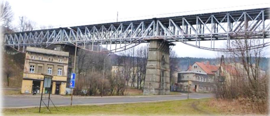
Zdjęcie 29. Wiadukt kolejowy nad ul. Niepodległości
