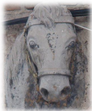
Zdjęcie 1. Pozostałość reliefu na bocznej ścianie dawnej kuźni
