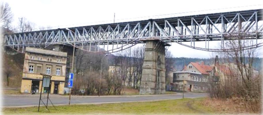
Zdjęcie 29. Wiadukt kolejowy nad ul. Niepodległości
