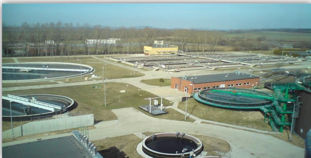
Zdjęcie 12. Widok na Oczyszczalnię Ścieków Ciernie; źródło: materiały WPWiK Sp.z o. o.;
