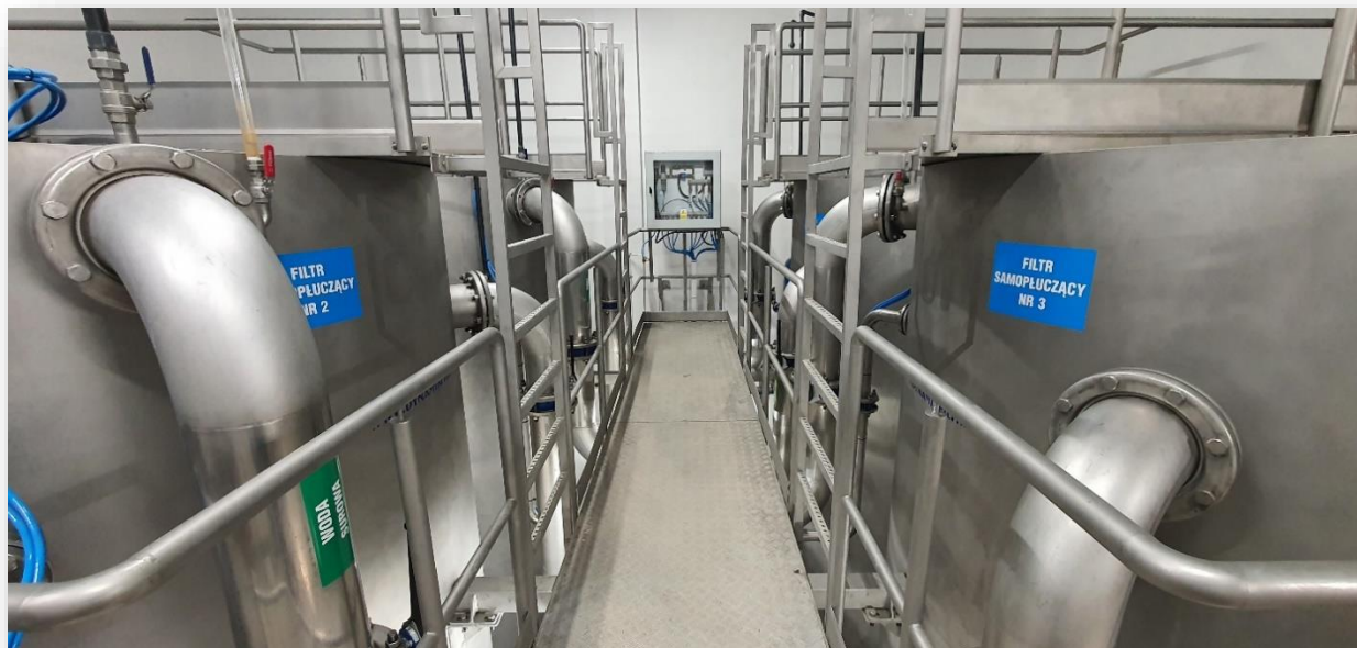
Zdjęcie 13. Filtry płuczące; źródło: materiały WPWiK Sp.z o. o.
