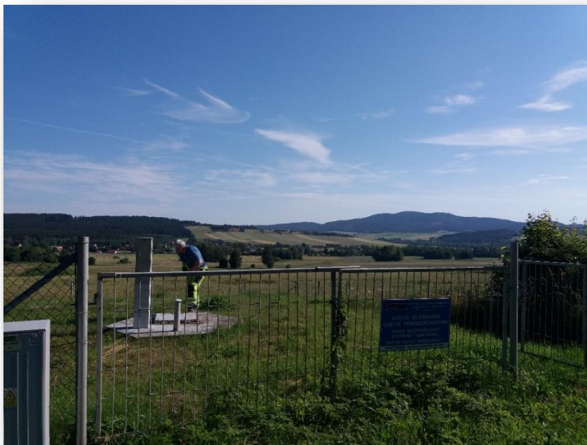
Zdjęcie 8. Ujęcie głębinowe wody powierzchniowej w Borównie; źródło: materiały WPWiK Sp.z o. o.
