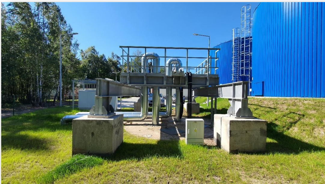
Zdjęcie 15. Punkt poboru wody z szybu pokopalnianego "Pokój" źródło: materiały WPWiK Sp.z o. o.;
