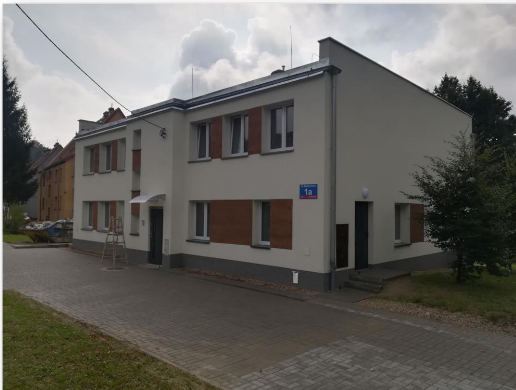
- budynek mieszkalny przy ul. Szczecińskiej 1a po przeprowadzonym remoncie i modernizacji budynku
