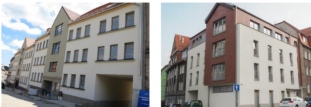
Nowe budynki komunalne w podobszarze Nowe Miasto. Fot. UM Wałbrzych
