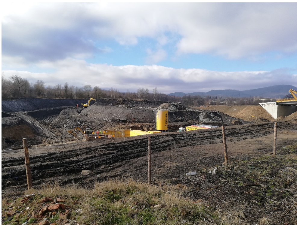
Rys. 1 Prace budowlane – węzeł Żeromskiego, źródło: KSR Marzec 2020
