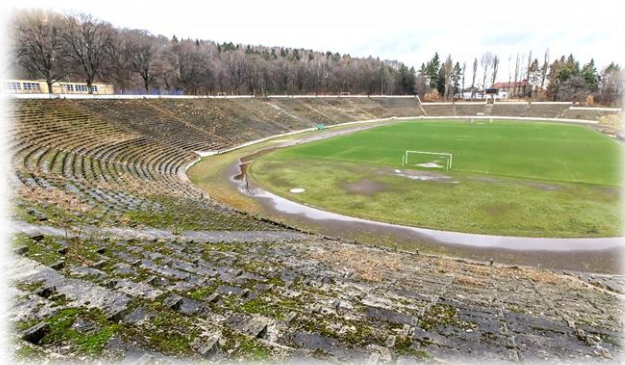
Zdjęcie 23. Stadion sportowy na Nowym Mieście
