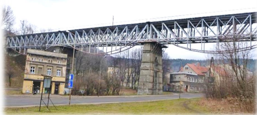
Zdjęcie 29. Wiadukt kolejowy nad ul. Niepodległości
