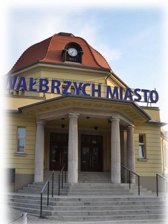
Zdjęcie 5. Budynek Dworca Miasto
