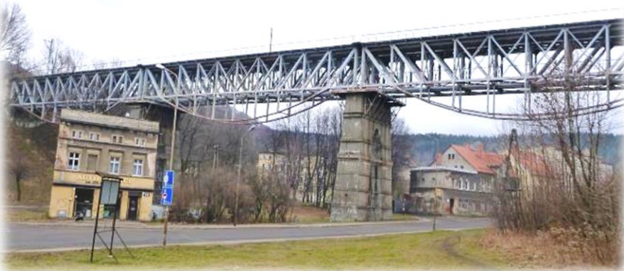
Zdjęcie 29. Wiadukt kolejowy nad ul. Niepodległości
