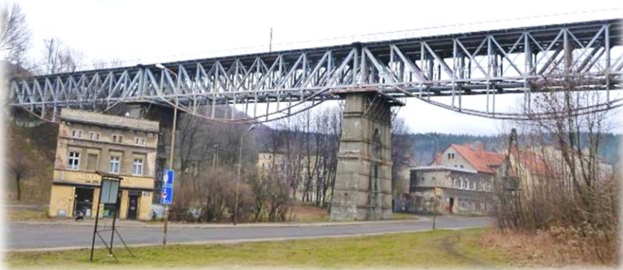
Zdjęcie 29. Wiadukt kolejowy nad ul. Niepodległości
