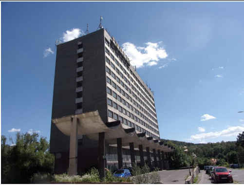
Zof. nr 1: Widok ogólny instalacji radiokomunikacyjnej.
