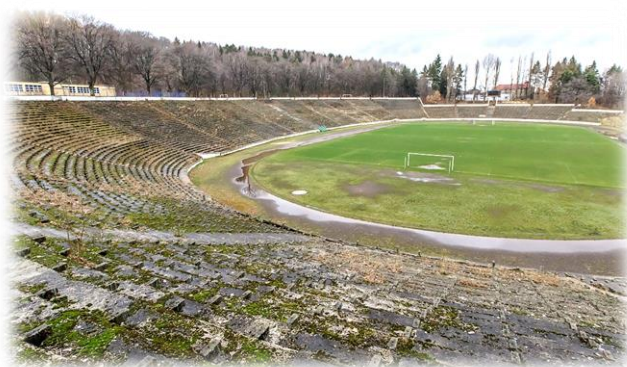
Zdjęcie 23. Stadion sportowy na Nowym Mieście
