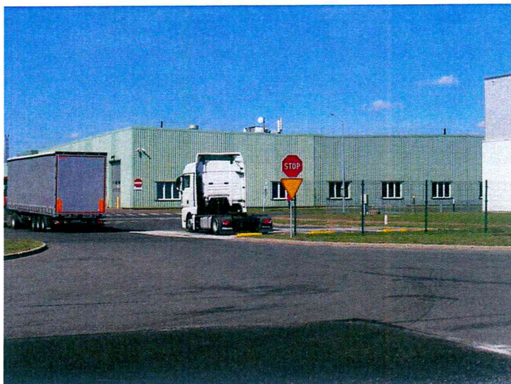
Zal. nr 1: Widok ogólny instalacji radiokomunikacyjnej.
