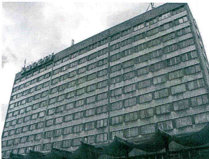
Zał. nr 1: Widok ogólny instalacji radiokomunikacyjnej.
