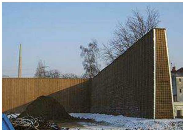
Rysunek nr 15. Przykładowy ekran akustyczny – ziemny ekran akustyczny z konstrukcją stalową. [Źródło: Ecotec Polska]
