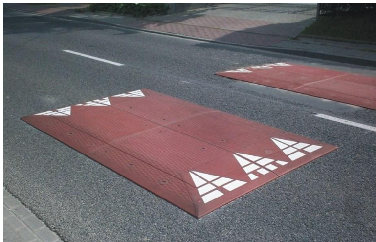
Rysunek nr 13. Przykład progu spowalniającego [Źródło: https://domino-znak.pl/progi-zwalniajace ]
