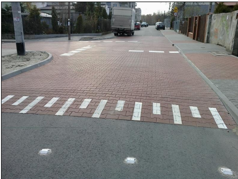
Rysunek nr 11. Przykład wyniesionego skrzyżowania [Źródło: zm.org.pl]
