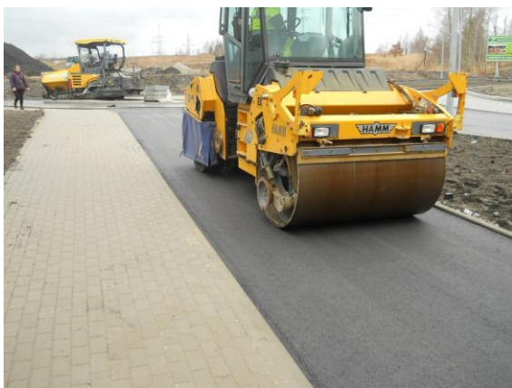
Budowa ścieżki rowerowej przy ul. Wysockiego
