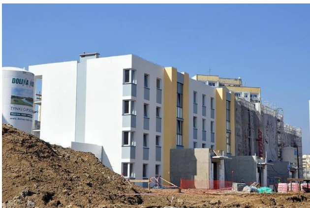
Budowa mieszkań komunalnych w dzielnicy Podzamcze
